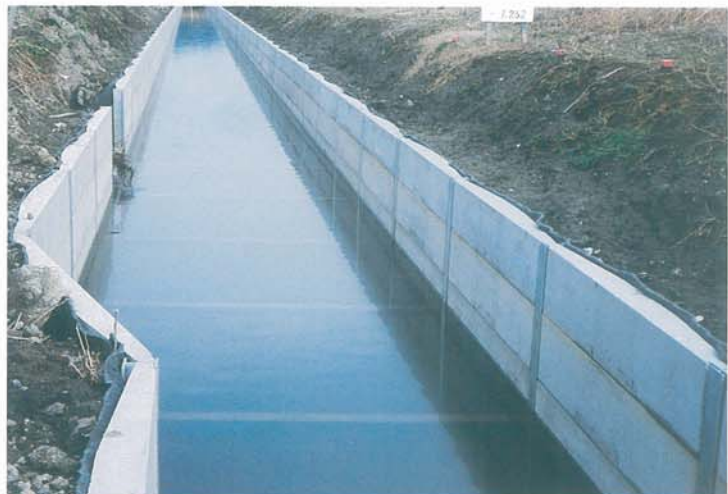
石川県羽咋農林総合事務所 羽咋市鹿島路 (防錆処理あり) (H900×B1600～H900×B2200)
