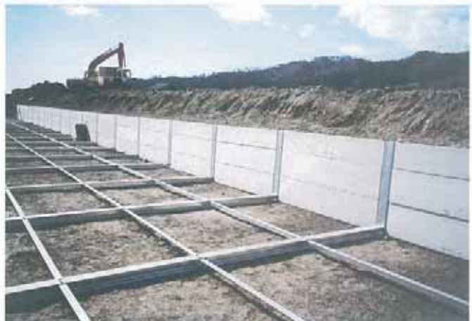
石川県羽咋農林総合事務所 羽咋市鹿島路（防錆処理あり） （H1000×B5600）
