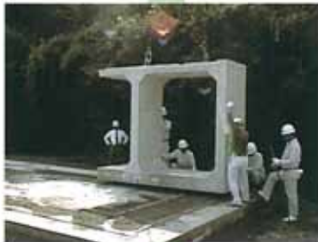
2. 端部ボックス据付
