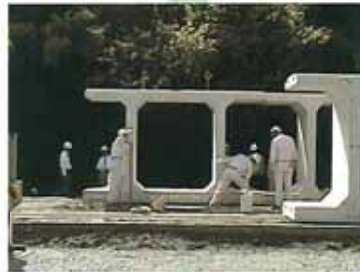
6. 基本ボックス据付
