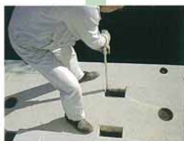
8. PC鋼棒締付 (トルクレンチ使用の場合)
