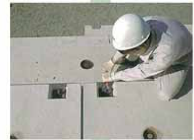
11. 頂版スラブ固定ボルト締付
