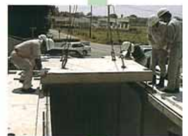
10. 頂版スラブ据付
